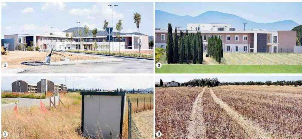
1. La Rsa di via Genova; 2. In primo piano il terreno su cui sorgerà la Rsa Villa Martini (Foto Bf) 3. La Rsa di via Genova vista dalla quattro corsie; 4. Il terreno in località via Serenissima
